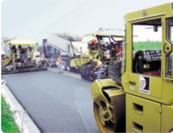
Einbau mit gestaffelt fahrenden Fertiggern
