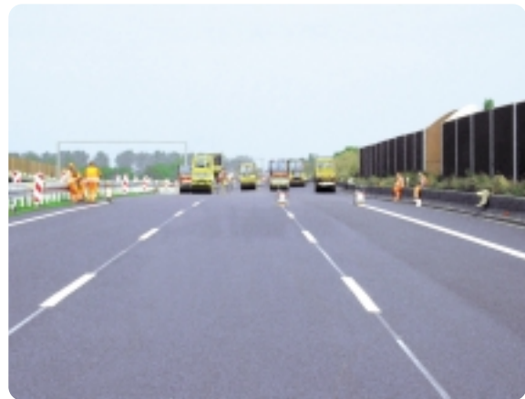
Markierungsarbeiten auf der fertigen Deckschicht
